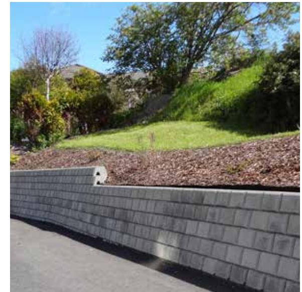
Enkel å stable i høyden når du trenger støtte for masse på ulike nivå. Legger du den så tett som på bildet, kan du godt gå to meter til værs. Steinene tørrstables uten bruk av mortel eller lim mellom lagene. Bare det øverste laget bør limes.
