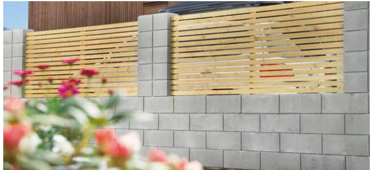
Forskalingsblokk tørrstables og helfylles med betong. Ferdigstøpte hjørne-, ende- og halvblokker gjør den enkel å jobbe med. Kan du bygge Lego, kan du bygge forskalingsblokk! Egne hjørneløsninger med høyre- og venstrehjørner, samt halvblokker, gjør forskalingskonseptet meget brukvennlig.
