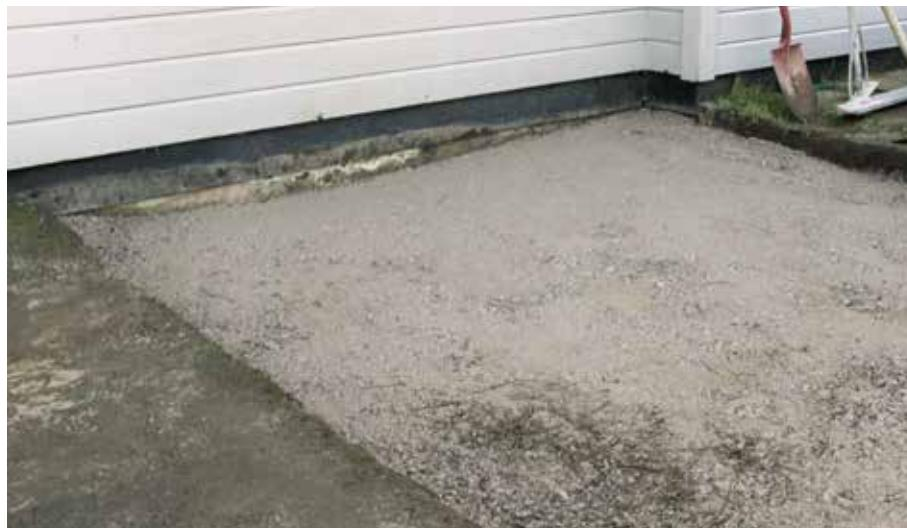
**6** Legg ut cirka 3 cm med settesand og komprimer dette lett. Plasser ut lirer (2-3 m lange jernrør eller stålprofiler) slik at kanten på liren har samme høyde som undersiden på belegget. Fjern overflødig settesand ved å trykke en rettholdt (planke eller lignende) mot liren og dra denne mot deg. Slik får du et ferdig underlag som belegget kan legges på. Fjern deretter liren og etterfyll forsiktig med sand.
