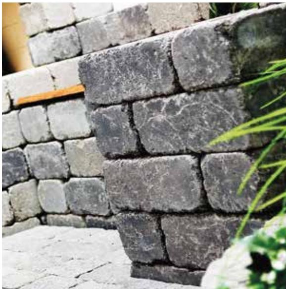
Kubbemur XL er dobbelt så bred som den er lang og gir den perfekte innramming av det øvrige steinarbeidet. Du kan også bruke den til trapper eller til lave murer. Den er tromlet for å gi et litt tøffere preg.
