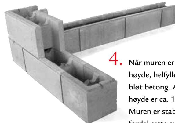
4. Når muren er bygget til ønsket høyde, helfyller blokkene med bløt betong. Anbefalt fyllingshøyde er ca. 1,2 m i hver omgang. Muren er stabil, men en kan med fordel sette avstivere vertikalt ved hjørner og ender før utstøping. Ferdig mur har en tilhærmet styrke som stedstøpt mur.
