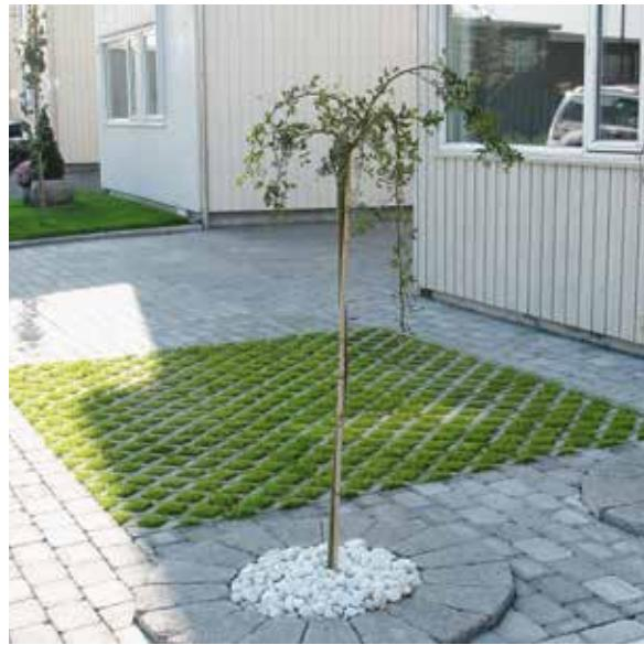
Borg Gressarmeringsstein har gjennomgående åpninger for planting av grønne. Det gir spennende muligheter både alene og sammen med en rekke andre belegningssteinprodukter. Den åpne konstruksjonen skaper også veldig god drenering.
