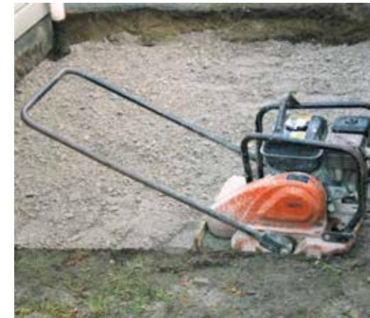
**4** Fyll opp med et 10-15 cm bærelag av 0/18 mm pukk eller tilsvarende masse. Hardpakk dette med en vibroplate eller hoppetusse. Jevn ut overflaten og sorg for at den får samme helling som den ferdige overflaten skal ha. Det skal være plass til cirka 3 cm med settesand, pluss tykkelsen på hellene eller belegningssteinen oppå dette.
